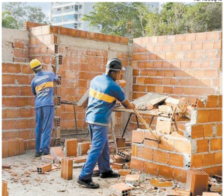
Terreno de 2,4 mil metros quadrados tinha três imóveis em alvenaria
